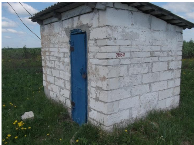
Фото 1.4.15 Строение из газосиликатного кирпича скважины № 2664 с. Сандогора
