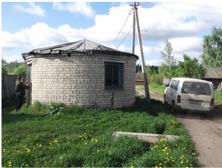
Фото 9.1.1 Строение КНС в пос. Мисково
