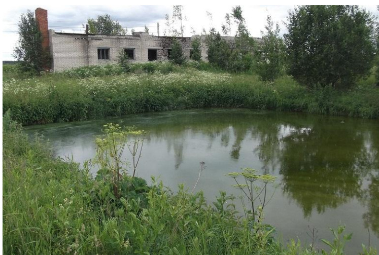
Фото 9.1.15 Пруд-отстойник первой ступени доочистки водостоков в с. Сандогора
