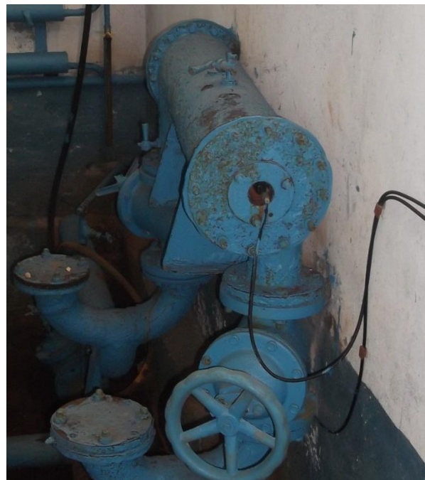
Фото 3.16.10 Бактерицидная лампа ДРТ-2500 для обеззараживания воды на станции СТРУЯ-200 пос. Мисково
