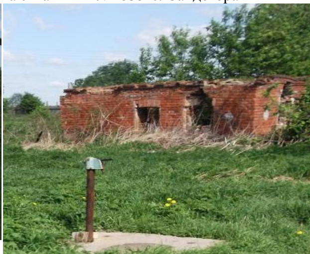
Фото 1.4.16 Водоразборная колонка на ул. Новый Починок с. Сандогора
