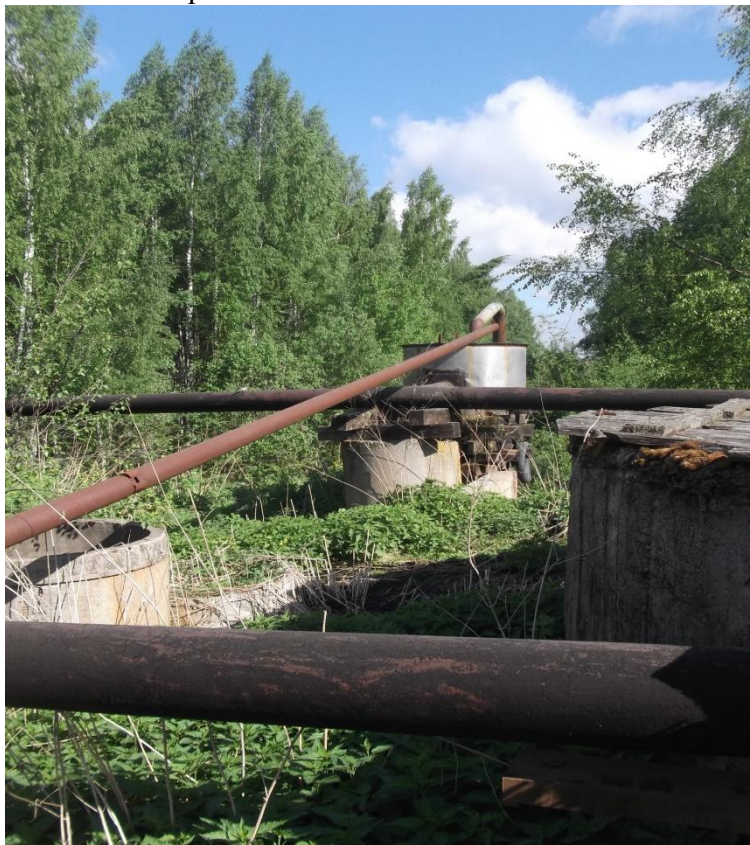
Фото 9.1.3 Распределение фекальных стоков на поля фильтрации за пределами пос. Мисково
