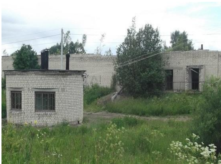
Фото 9.1.11 Поверхностный вывод трубопровода фекалий из КНС второго подъёма сквозь зал аэротэнков на пруды-отстойники в с. Сандогора
