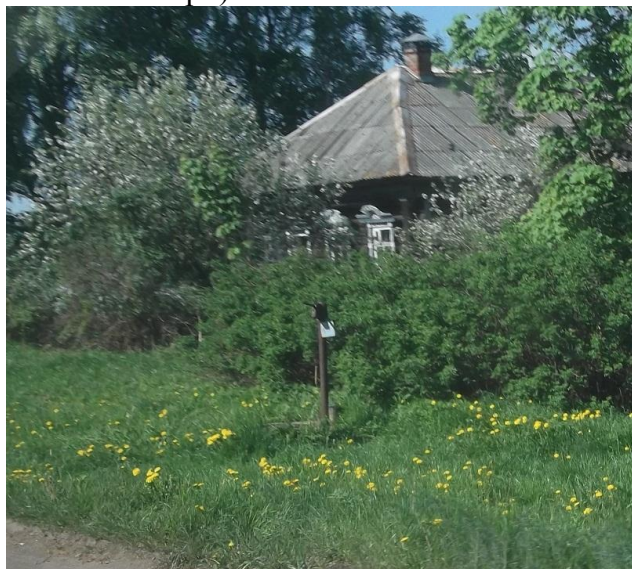
Фото 1.4.10 Водоразборная колонка в д. Колесово
