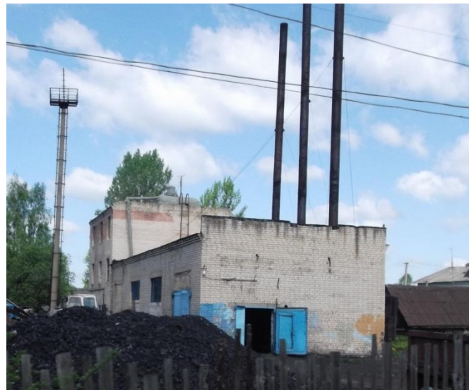
Фото 1.4.18 Котельная горячего водоснабжения с. Сандогора
