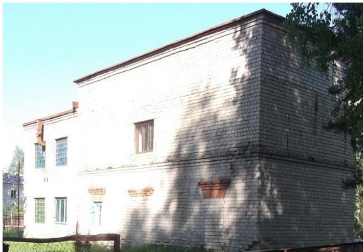
Фото 1.4.5 Здание станции водоочистки «Струя-200» в пос. Мисково
