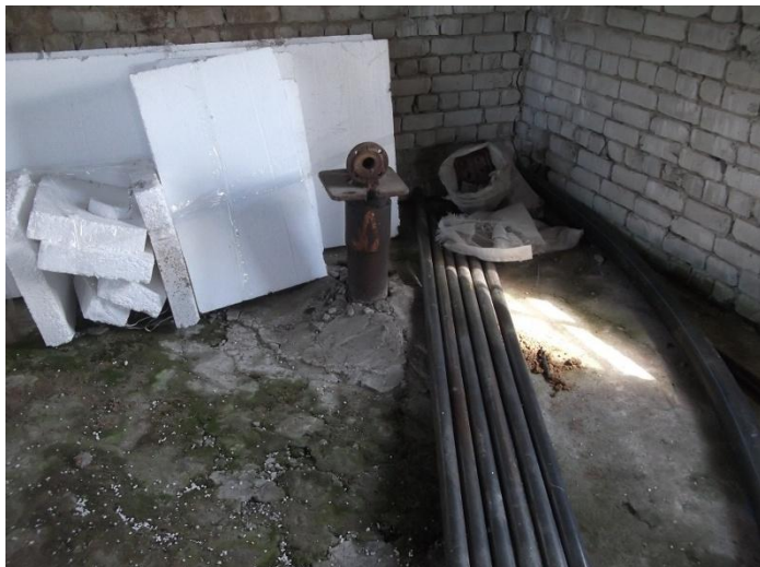
Фото 1.4.17 Тампонирующая скважина в с. Сандогора
