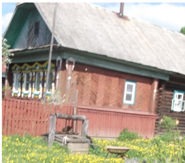
Фото 1.2.1 Уличный водоразборный колодец в с. Сандогора ул. Новый Починок
