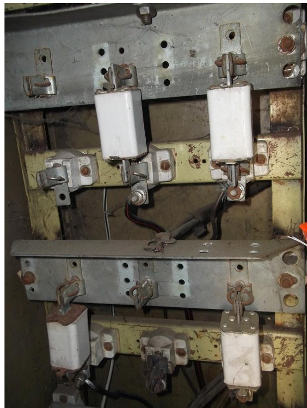
Фото 3.16.6 Предохранители с плавкими вставками ВРУ на «Струя-200» пос. Мисково
