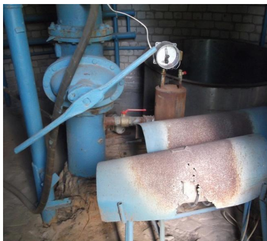
Фото 1.4.8 Водонапорная башня (вид изнутри) в пос. Мисково
