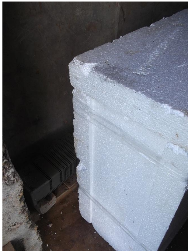
Фото 1.4.22 Утепление скважины №4407 в с. Фоминское
