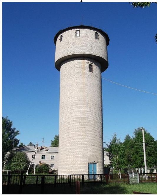
Фото 1.4.4 Водонапорная башня в пос. Мисково
