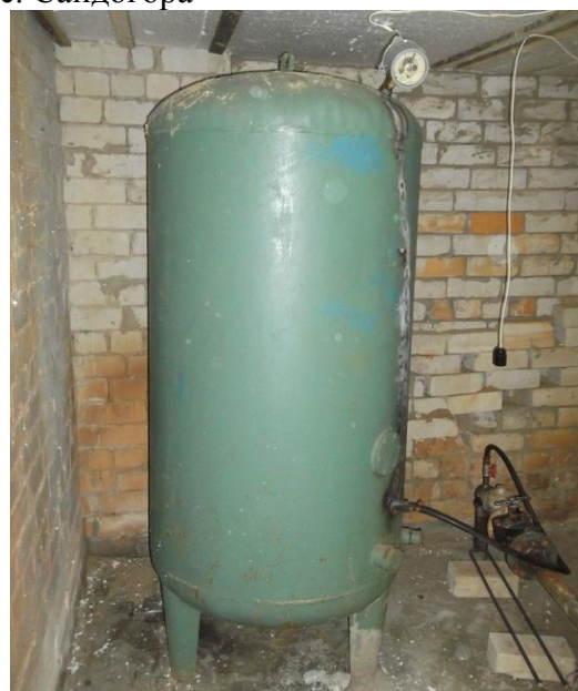
Фото 1.4.20 Гидроаккумулятор насоса скважины №4406 с. Фоминское
