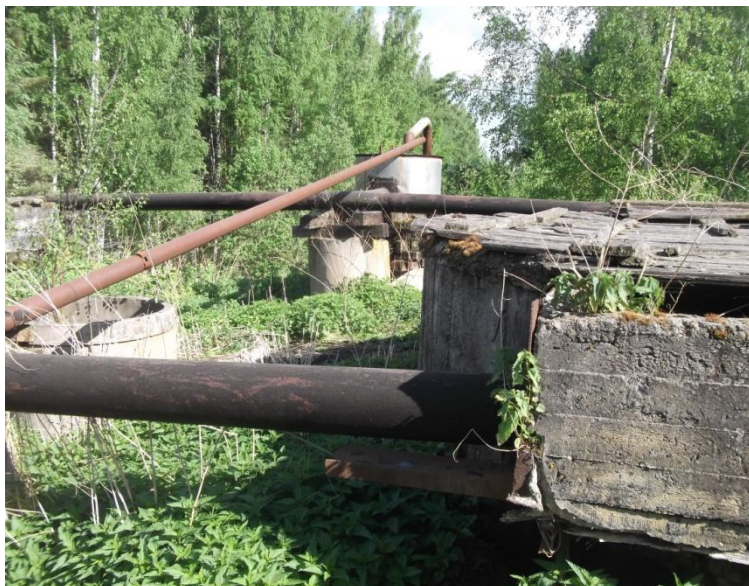
Фото 9.1.5 Группа отстойников перед выпуском на поля фильтрации пос. Мисково
