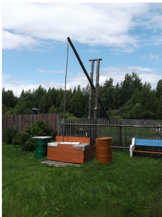
Фото 1.2.3 Уличный водоразборный колодец в д. Нукша
